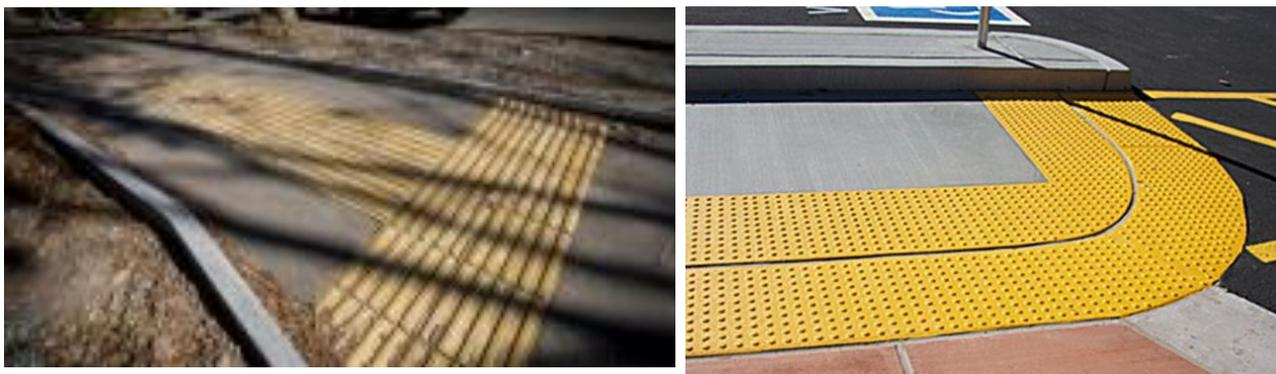
Рисунок 4 – Изменение направления продольных полос на поворотах тропы
