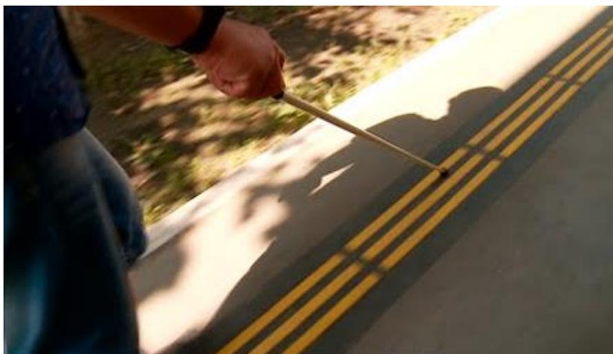
Рисунок 2 – Специальные ограничения на тропе для нащупывания ее концом трости
