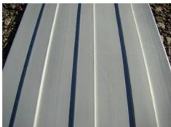
Рисунок 3 – Тактильные полосы и тактильная лента направляющая
