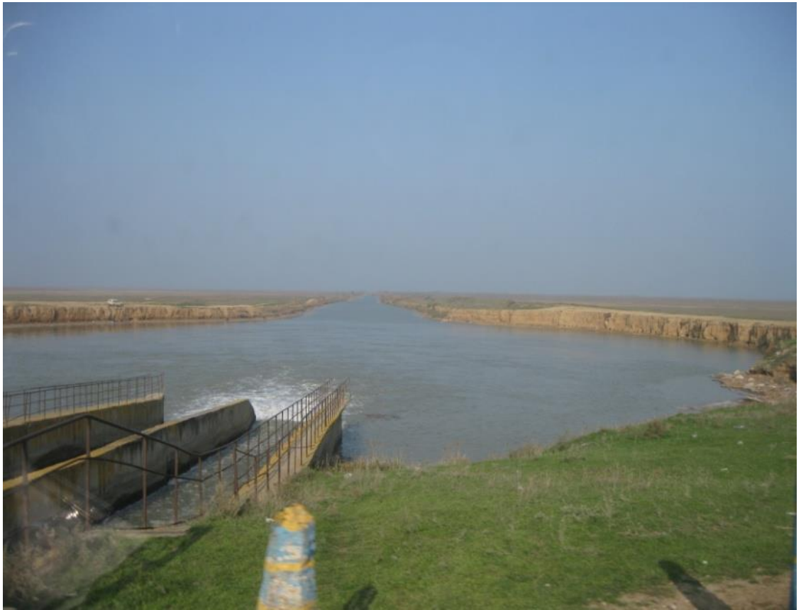
Рисунок 29. – Плотина на участке Чограйского водохранилища
